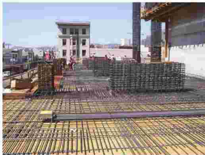
شکل 6-9. تداخل بین موقعیت آرماتور کلکتور و جزء غیر سازه ای
