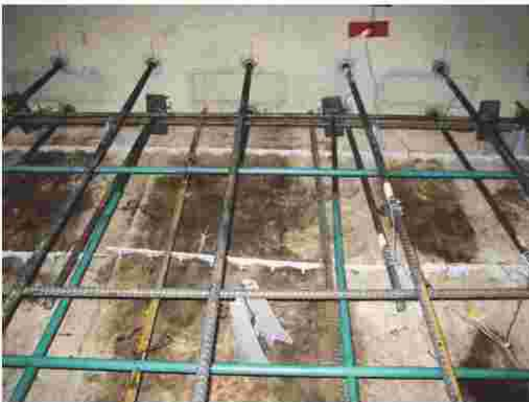
شکل 4-9. کوپلر form-face جهت مهار میلگرد انتظار
